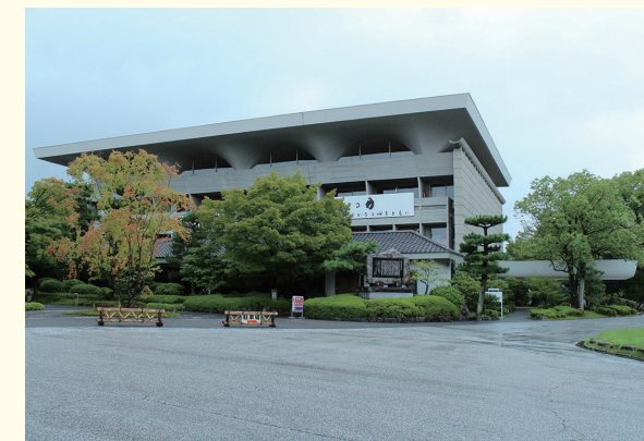
写真2: 北側外観。大きな屋根が建物から浮かび上がるように載っている。開口部も上に行く程、大きくなる。西側には大きな庇が付いている。(筆者撮影)
