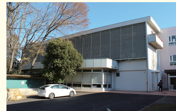
写真3：「学生食堂」外観。建物上半分にかかっているのが「サンコントロールルーバー」で、簾のように見える。（筆者撮影）
