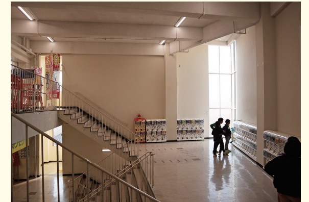
写真2: 階段室の内観。ゆったりとした踊り場が印象的。(筆者撮影)
