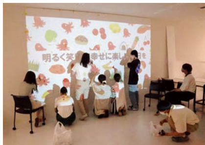
図案を壁面に投影し、下地のステンレボードに輪郭を書き込んでいます。
