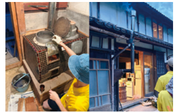
炊飯できるように改修した釜戸
