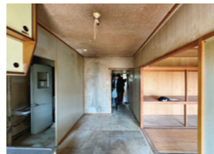
改修前の団地の様子
