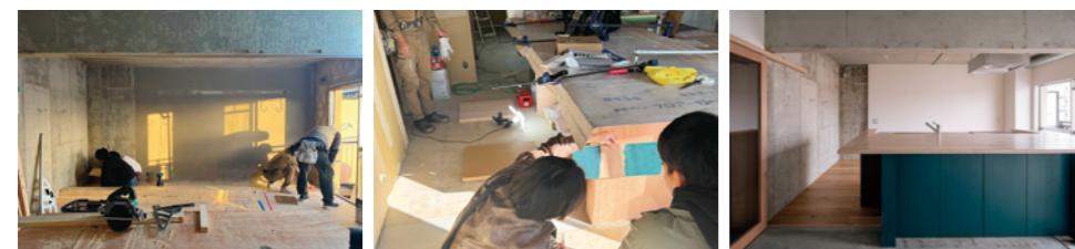
相談しながら施工を進めている様子
