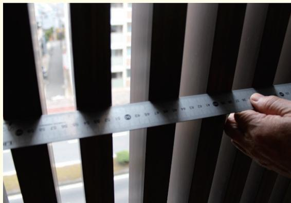
写真2：アルミ製のスクリーン。見付35mm見込60mm、間隔も35mm。2つの袖壁の間に20本ずつ設置されている。(筆者撮影)
