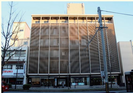
写真1：西側外観。西日除けに取り付けられたアルミ製のスクリーンで全面が覆われている。(筆者撮影)
