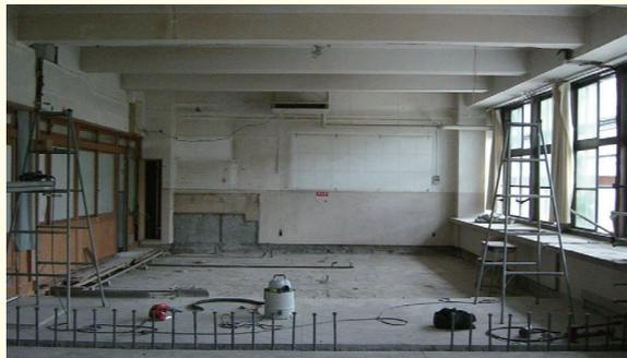
写真1：教室内観。南側に大きな開口部があり非常に明るい。現在改装工事中で、床から鉄筋の出ているところにもともと壁があった。(近藤先生撮影)
