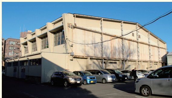
写真3：南東側外観。南側には大きな窓と逆三角形の壁柱が、東側には鉄骨製のトラス柱が見える。(筆者撮影)
