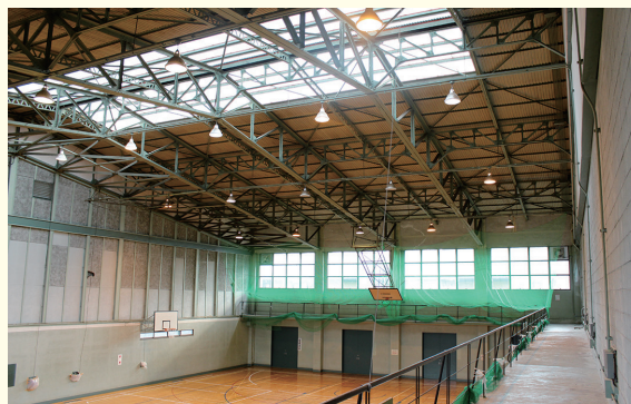
写真1：体育館内観。屋根の中央部と壁面上部に開講が取られており、光が差し込んでいる。(筆者撮影)
