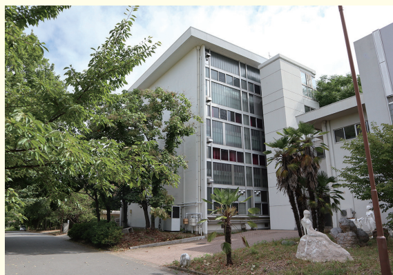
写真1:「2号館A棟」プロフィリットガラスが用いられた外観。右側のエレベーターは、近年増築されたもの。(筆者撮影)
