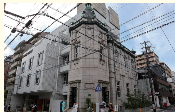
写真3: 「日本生命保険京都三条ビル」南東側外観。各所に装飾が残るものの、壁面は一色に統一されている。(筆者撮影)
